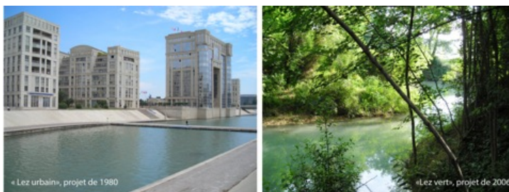
Figures 2a et 2b. Deux visions du fleuve dans la ville de Montpellier : le Lez urbain (projet de 1980), témoignage d'une époque célébrant la maîtrise humaine du fleuve et le Lez vert à Lavalette (projet de 2006), faisant la part belle aux ripisylves en place (photographies : Fanny Romain, mai 2008).
