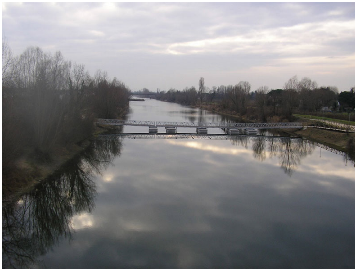
L'alveo dell'idrovia abbandonata nei pressi di Vigonovo (Pd).
